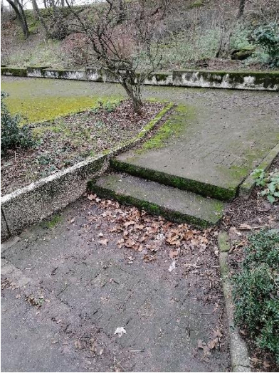
Bild F: Fehlende Gehwegplatte
